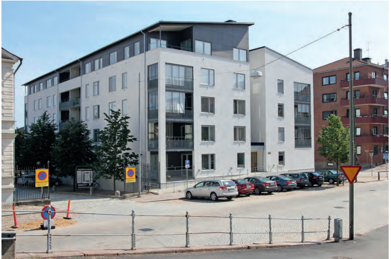
Brf. Bataljonen från huvudingångssidan mot Drottninggatan. De gemensamma lokalerna ligger i det närmaste hörnet med insyn från gatan och från entréutrymmena på bottenplanet. Foto: Kerstin Kärnekull.
