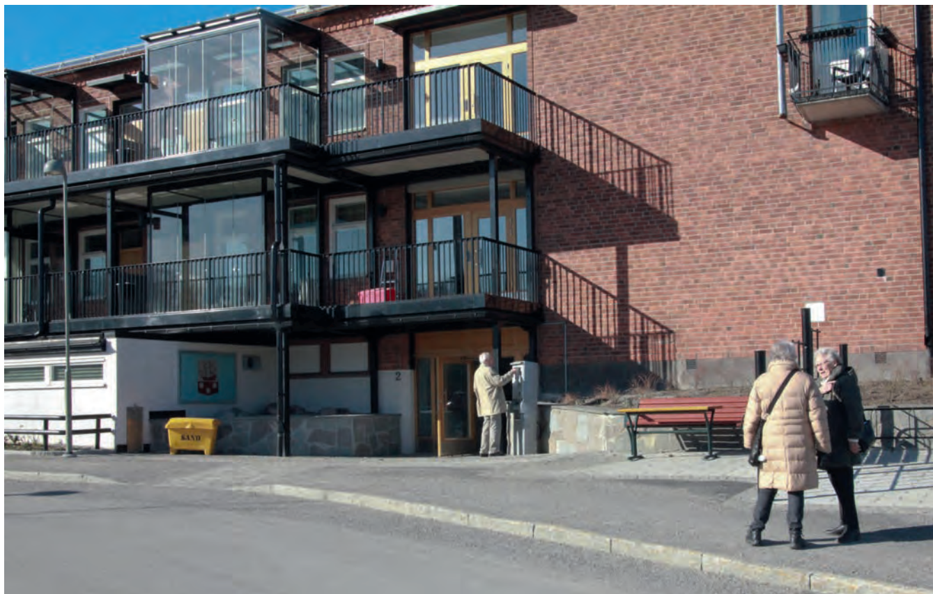
Det ombyggda kommunalhuset med gemensamma lokaler i bottenvåningen (Klubbhuset) och bostäder ovanpå. Foto: Kerstin Kärnekull.
